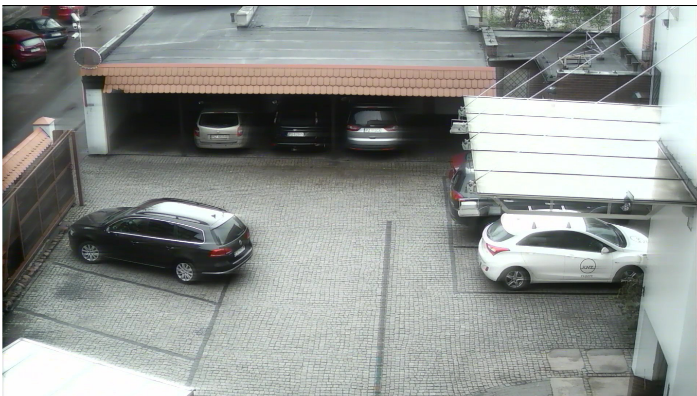
2.7 System AHD. Kabel RG-59 z regeneratorem na końcu kabla. Długość 900m.
