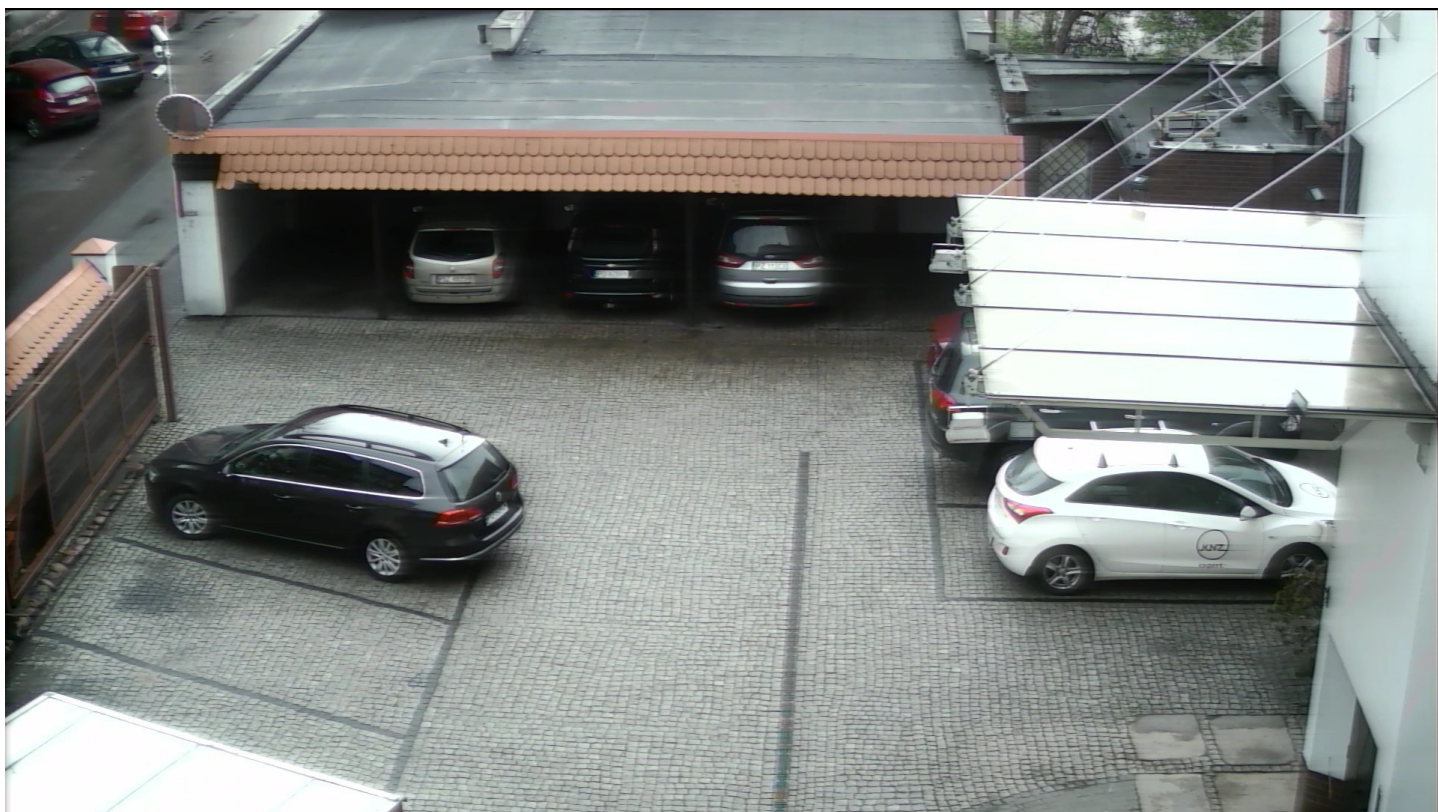
2.5 System AHD. Kabel RG-59 z regeneratorem na końcu kabla. Długość 700m.
