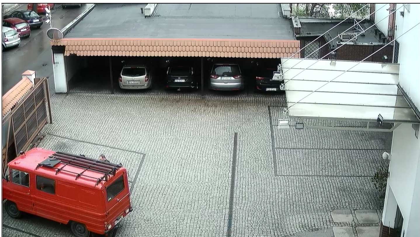
4.3 System AHD. Kabel RG-59 z regeneratorami na początku w środku i na końcu kabla. Długość 1000m.
